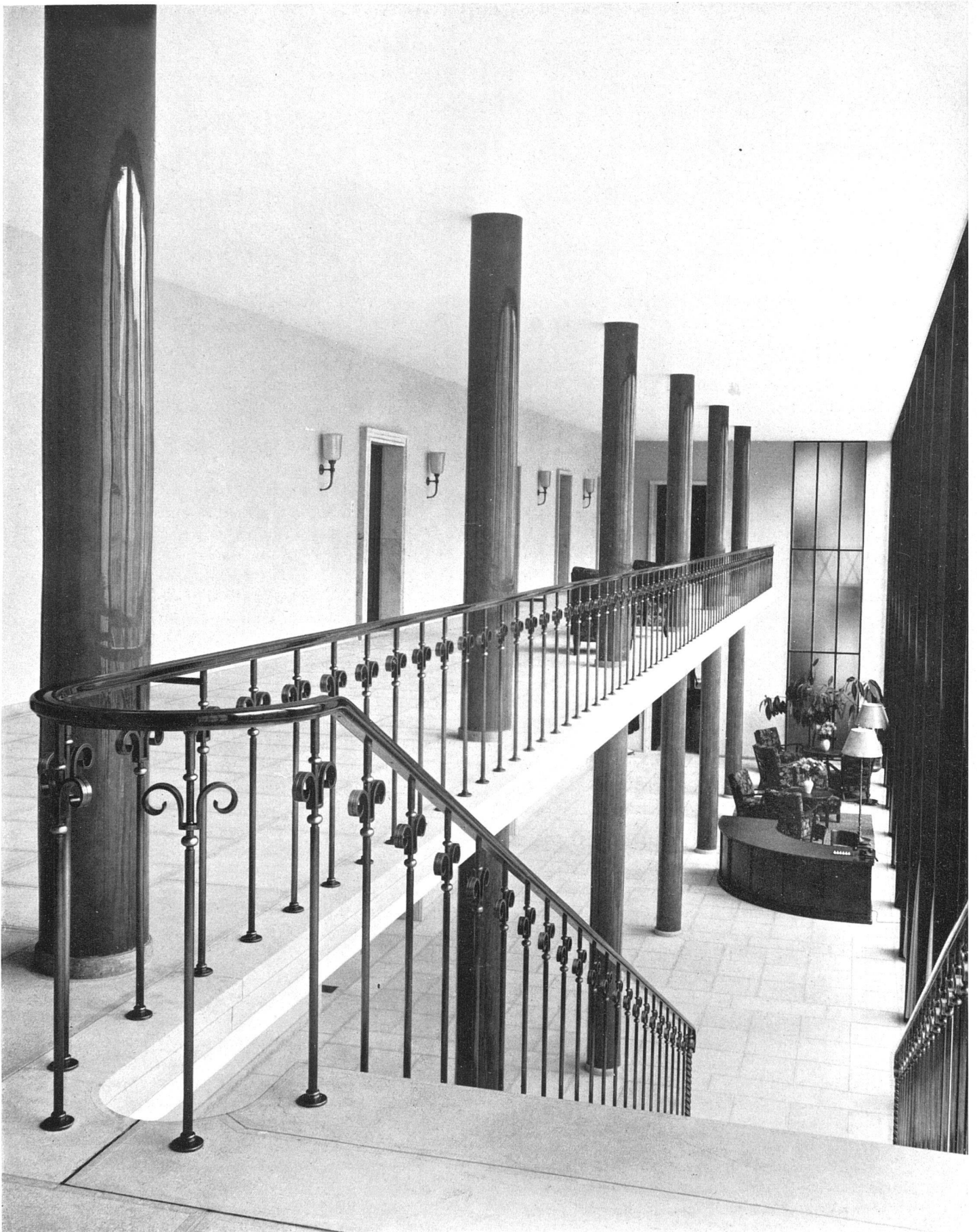
Empfangshalle. Bodenbelag in gelblichem Laufenerstein, Wände naturfarbener Putz, Säulen dunkelbrauner Stuck mit Hochglanz, Fensterrahmen in Mahagoniholz, Geländer in Bronze
