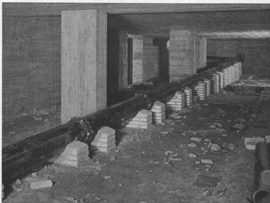
Eine der grossen Ablaufleitungen von 300 mm Ø
