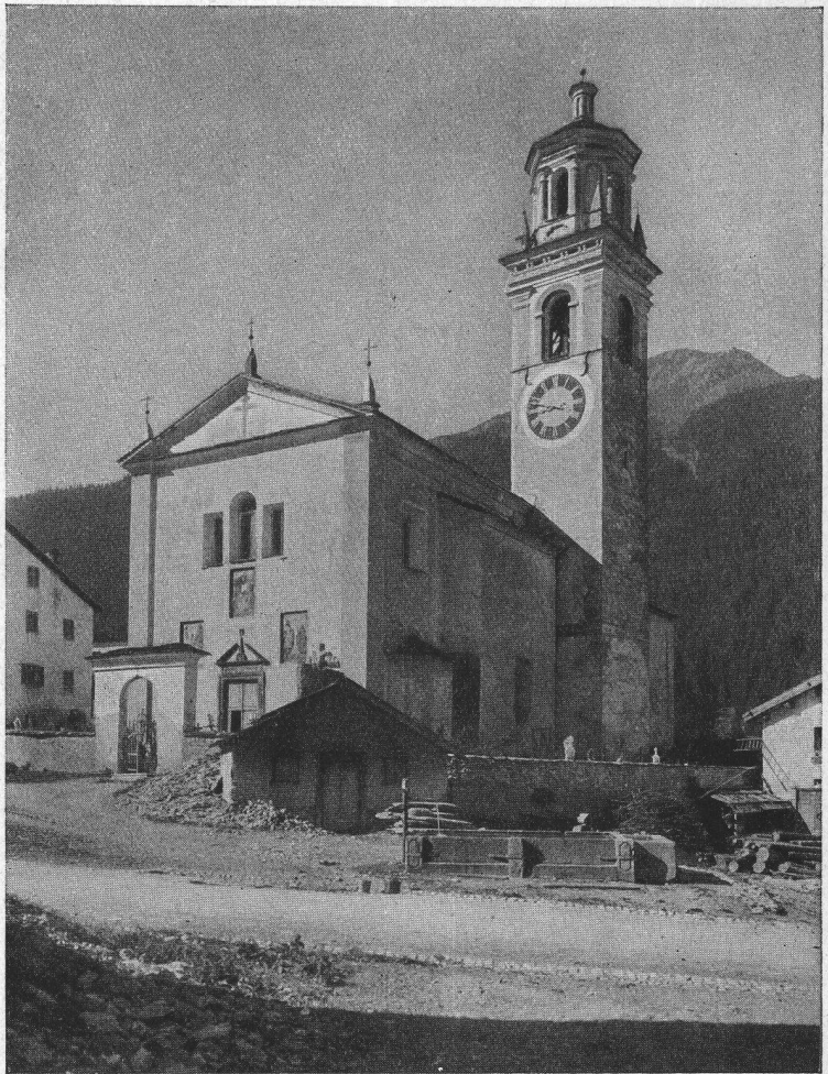
Tinzen, Oberhalbstein. Pfarrkirche St. Blasius. Neubau geweiht 1663; untere Turmggeschosse romanisch
