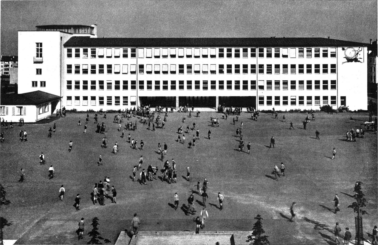
Gottfried-Keller-Schulhaus. Blick über den grossen Pausenhof nach der Südseite Die Eingangshalle dient auch für Pausenaufenthalt bei schlechtem Wetter. Links der Gebäudetrakt der Spezialklassen und der Aula, darüber teilweise mit Glasaufbau überdeckte Terrasse für Freiluftunterricht. Als niedriger Erdgeschossvorbau die Abwartwohnung. Am rechten Fassadenende Sonnenuhr von Karl Hindenlang. Im Vordergrund flacher Trinkbrunnen, der noch plastischen Schmuck durch Bildhauer Zschokke erhalten soll. Foto H. Eidenbenz SWB, Basel
