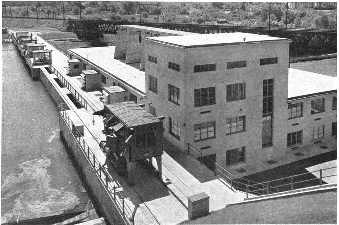
Stauwehr und Maschinenhaus, Oberwasserseite Ansicht aus Nordwesten
