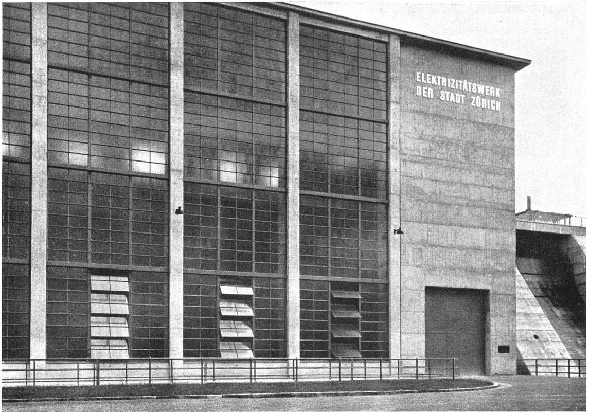
Limmatwerk Wettingen, Maschinenhaus Gebrüder Pfister, Architekten BSA, Zürich
