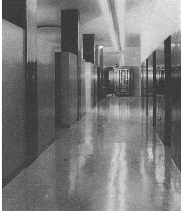
Couponkabinen Pfeiler und Kabinenwände mit dunkelbraunen Gummipplatten von 3 mm Dicke verkleidet
