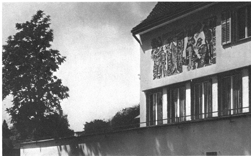
Prof. A. Babberger, Karlsruhe Farbiges Sgraffito an einem von Armin Meili, Arch. BSA, Luzern errichteten Wohnhaus in Luzern Gesamtansicht
