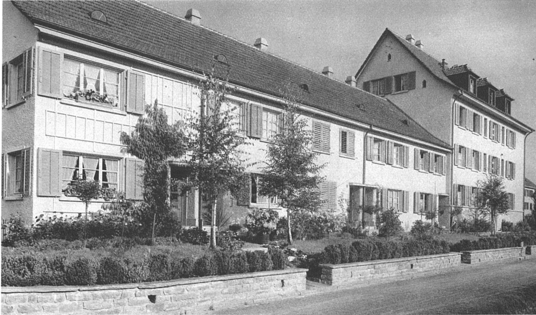
Einfamilien-Reihenhäuser der «Allgemeinen Baugenossenschaft Zürich» in Oerlikon, erbaut 1928 Karl Scheer, Architekt BSA, Oerlikon-Zürich
