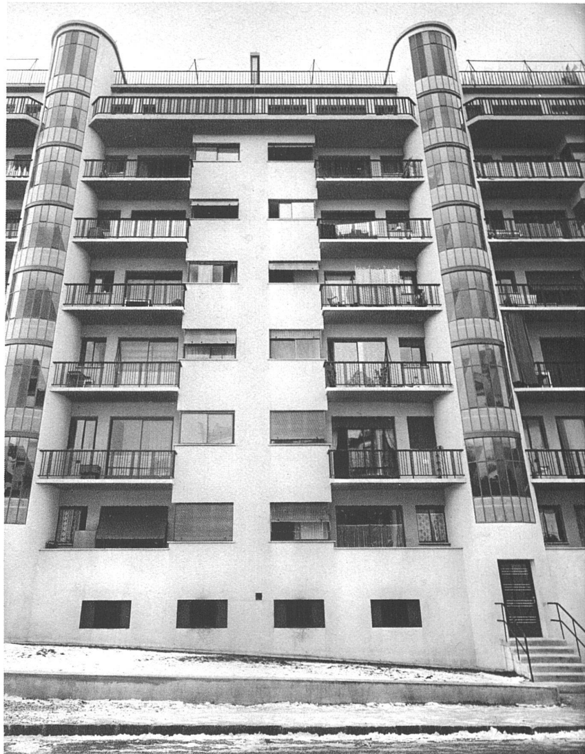
Façade postérieure avec les cages d'escalier
