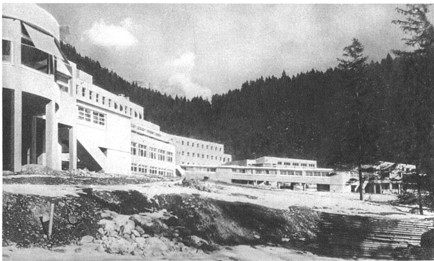
Ansicht aus Südwesten
