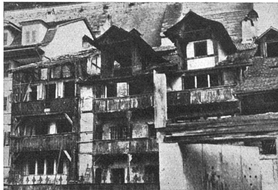
Die Badgasse am Fuss der Berner Münsterterrasse vor der Sanierung
