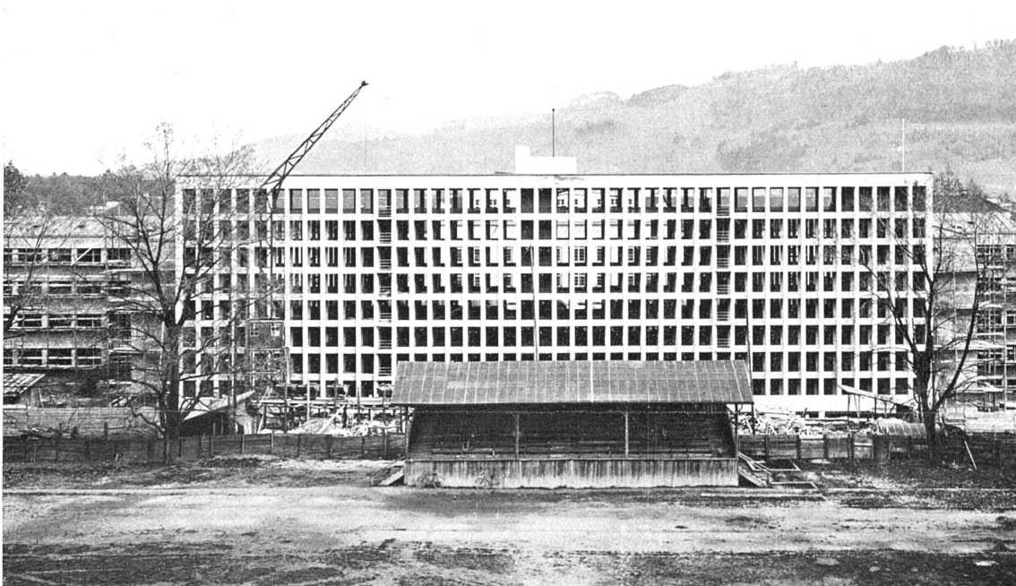
Das Büchermagazin von Norden gesehen, Rohbauaufnahme vom 22. April 1930
