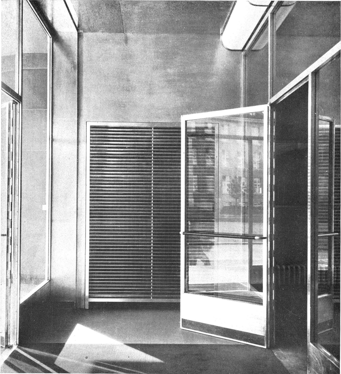
Der Windfang des Haupteingangs die Metallteile der Glastüren, Glasabschlüsse und Treppengeländer in Anticorodal
