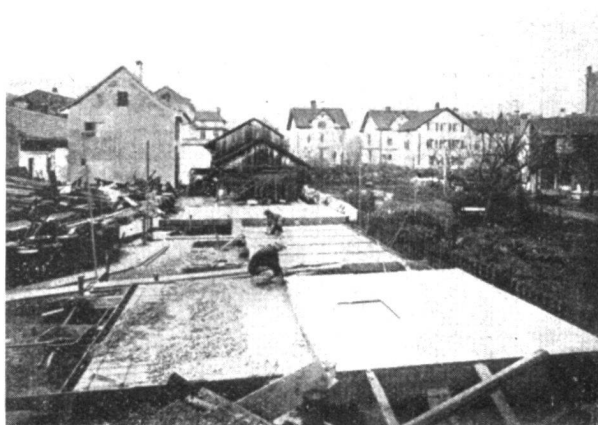
Garage / Betonieren der Wände
