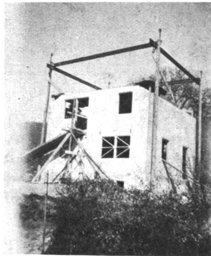
Einfamilienhaus / Rohbau fertig, zum Einbetonieren der Zwischendecken
