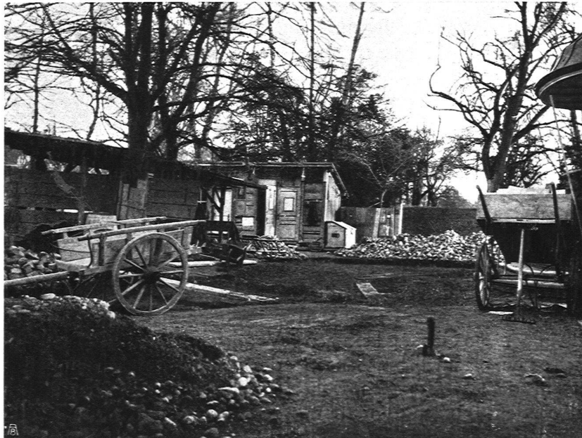
Abb. 7. Derselbe Platz wie oben vor der Umgestaltung
