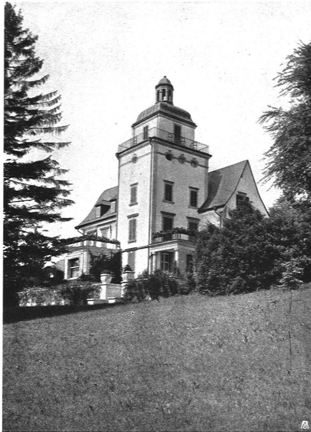
Abb. 3. Gartenanlage Dir. Schindler-Escher Zürich Entwurf und Ausführung: Gebr. Mertens, Zürich
