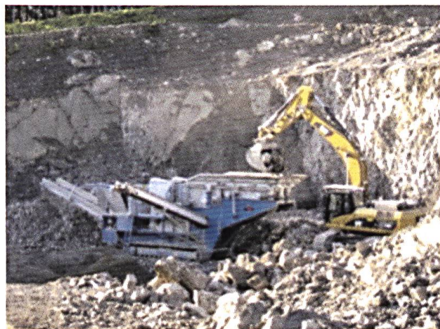
Fig. 3: Beispiele aktueller Rohstoffgewinnung in Kalksteinbrüchen.
