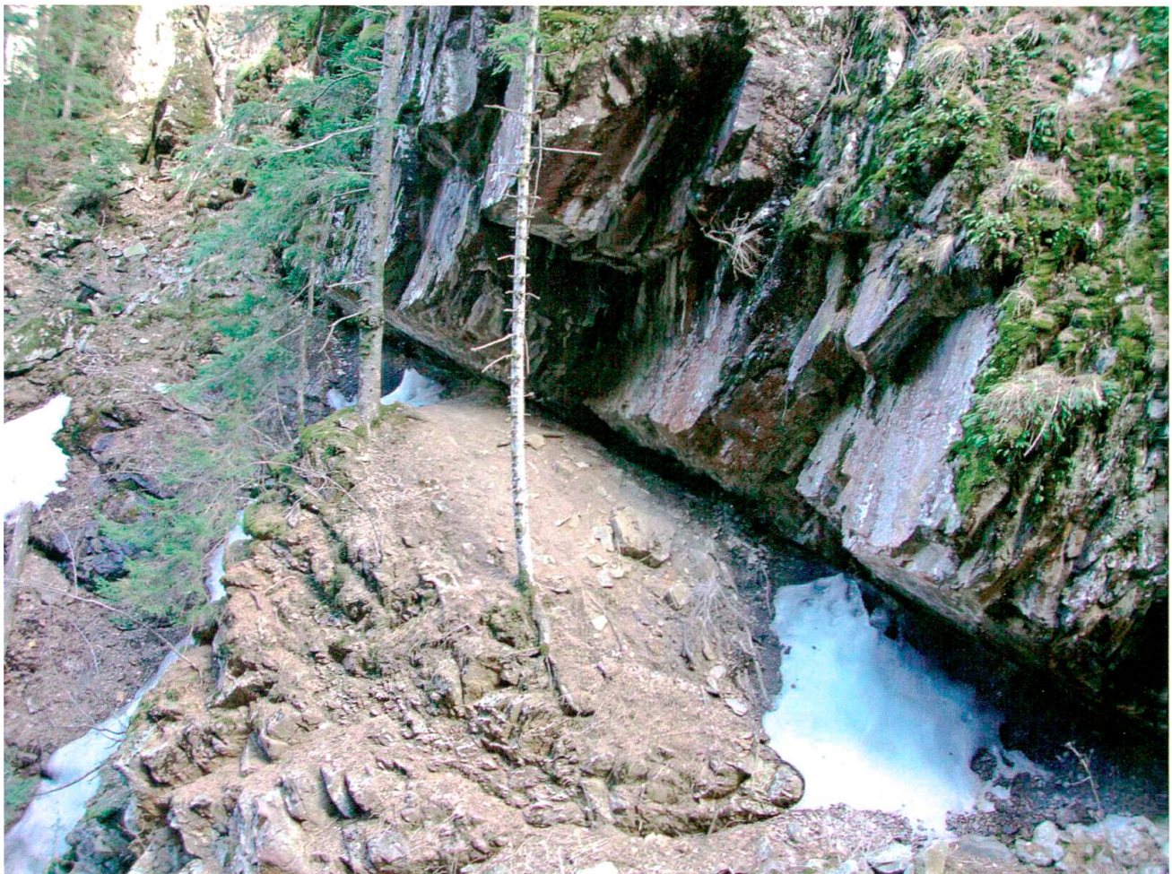
Fig. 4: [Oben] Bautechnisch risikobehaftete mylonit- bis kakiritisierte basale Überschiebungszonen der Bernina-Decke. Bohrkern: lagenweise kakiritisierte Dolomite, Rauwacken und Paragneise (Altkristallin) im Alv-Zug (vgl. Fig. 3). [Unten] Ansicht der Tobelflanke Crodalöc über der Kavernenzentrale Camp Martin (Lago di Poschiavo): Überschiebung von massigem Brusio-Granit auf intensiv zerscherter Marinelli-Formation (Paragneise, vermutlich metamorphe Quarzphyllite der Ostalpen) der Sella-Decke (vgl. Fig. 8 und 9).
