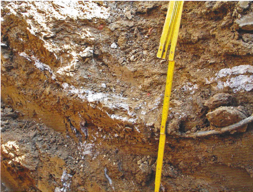
Fig. 12: Oberer Injektionsbereich im Tegel.
