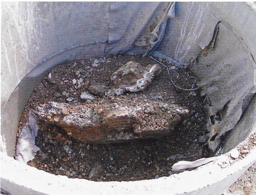
Fig. 8: Injektionsbereich in Leithaschotter.
