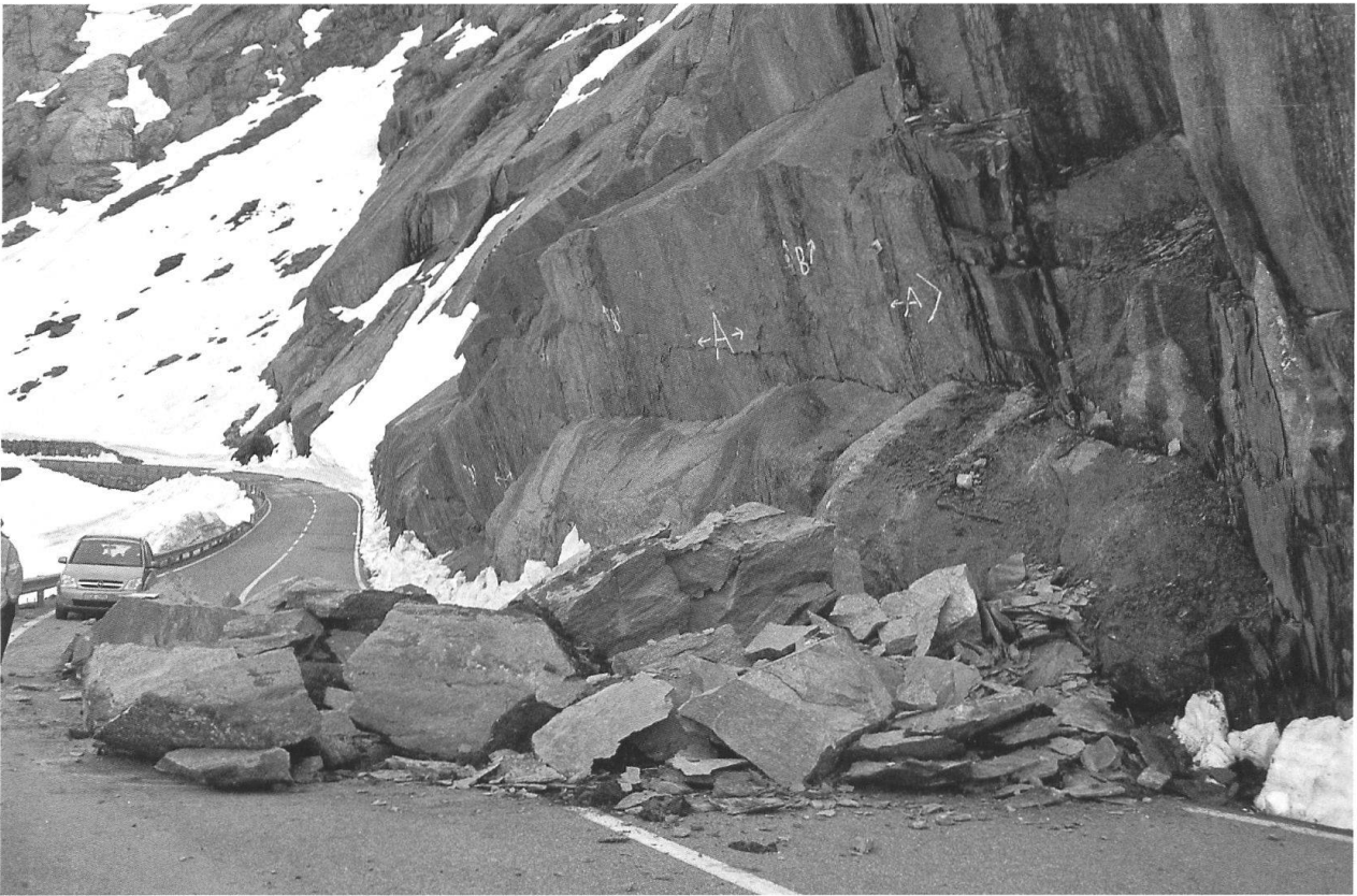
Fig. 2: Beispiel eines Sturzereignisses im Frühling mit einer grösseren Anzahl von kleinen Blöcken: An der Grimselpassstrasse (Kanton Bern) stürzten im Mai 2007 nach einem kalten Winter rund 30 \text{ m}^3 Fels auf die Strasse.
