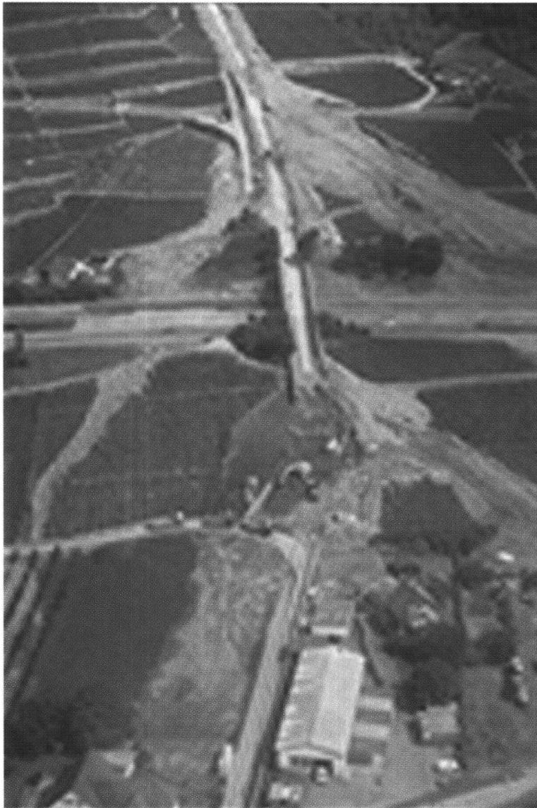
Fig. 1: Vue aérienne de la zone sinistrée
