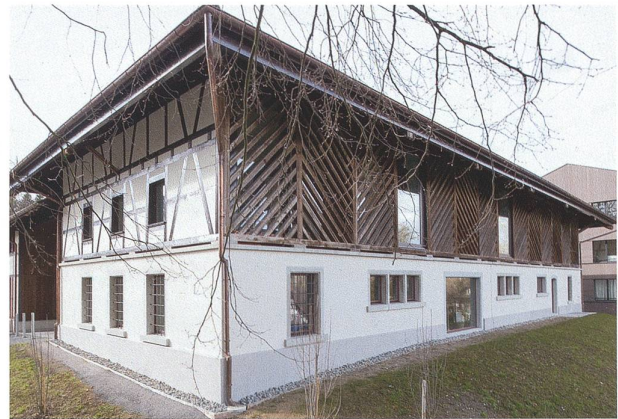
Abb. 28 Cham, Sinslerstrasse, Gutshof Hammer. Ehemaliger Pferdestall. Ansicht von Osten.
