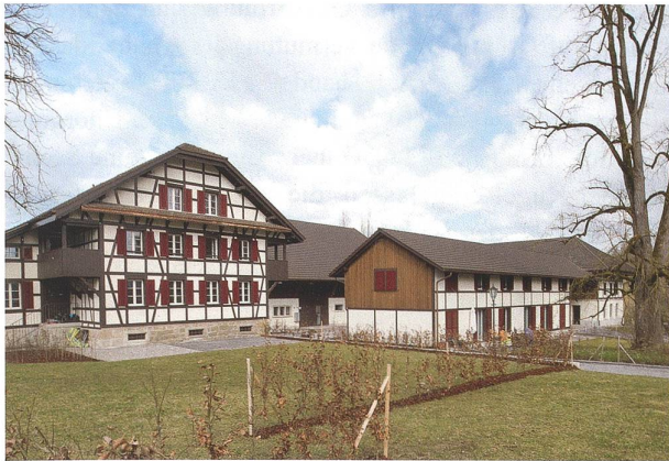
Abb. 26 Cham, Sinslerstrasse, Gutshof Hammer. Ansicht von Süden.
