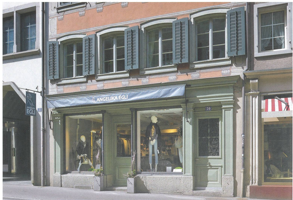
Abb. 42 Zug, Neugasse 20, Wohn- und Geschäftshaus. Ansicht von Osten.
