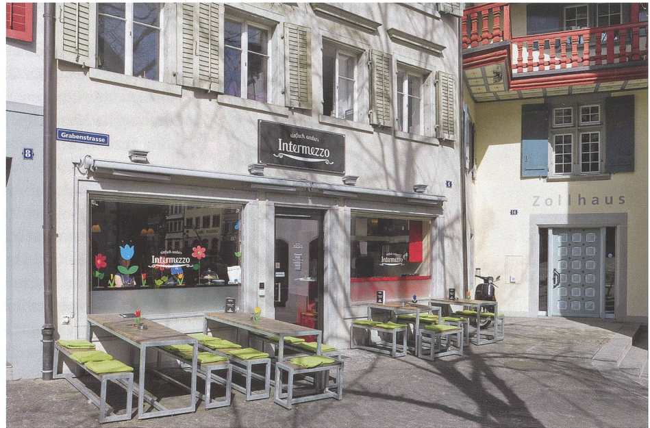
Abb. 39 Zug, Grabenstrasse 6, Wohn- und Geschäftshaus. Ansicht von Südosten.
