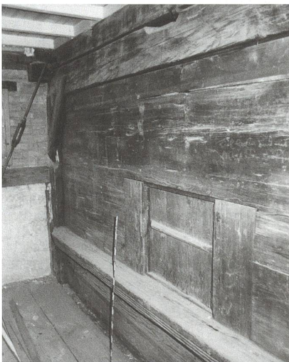
Abb. 50 Zug, St.-Oswalds- Gasse 5a, Pfrund- haus St. Anna. Zweites Ober- geschoss, Laube, südliche Aussen- wand. Blick von Südosten. Zustand 1982. Die Bohlen- Ständer-Konstruk- tion ist vollkommen intakt.
