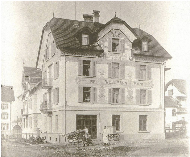
Abb. 6 Haus des Malermeisters Johann Wesemann an der Erlenstrasse, errichtet 1902/03, auf einer Fotografie von Heinrich Grau von 1904. Malermeister Wesemann benutzte seine Hausfassade als Referenz seines Könnens im Bereich der Dekorationsmalerei. Links anschliessend das Haus des Zimmermeisters Robert Banzer; ebenfalls von 1902/03. Links angeschnitten die Wagnerei von Josef Weiss von 1899, rechts angeschnitten das Wohnhaus mit Werkstätte von Robert Brandenburg, auch von 1902/03.
