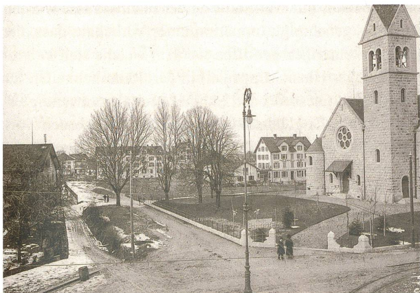
Abb. 9 Der Blick über die Kreuzung Bundesstrasse/Alpenstrasse Richtung Nordwesten zeigt links hinter den Bäumen das Wohnhaus Klausenhof von 1898/99, rechts davon das Lagerhaus Felber von 1881, dann die Wagnerie Weiss von 1899 und schliesslich die reformierte Kirche von 1904/06. Die Fotografie diente den Architekten Keiser & Bracher für die Studien zum kommenden Neustadtschulhaus.
