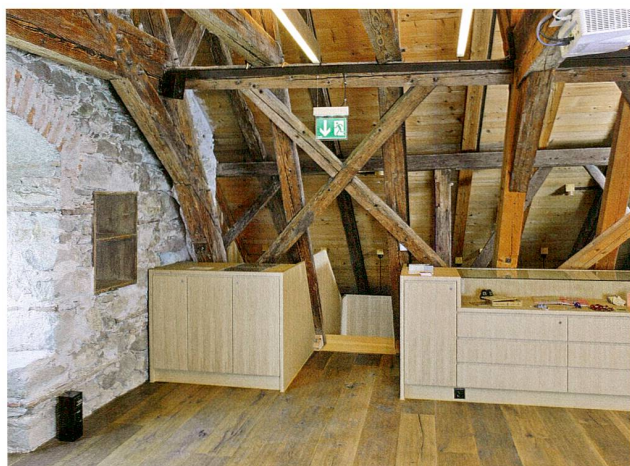
Abb. 62 Zug, Kirchenstrasse 11, Burg. Neuer Kulturvermittlungsraum im Dachgeschoss.
