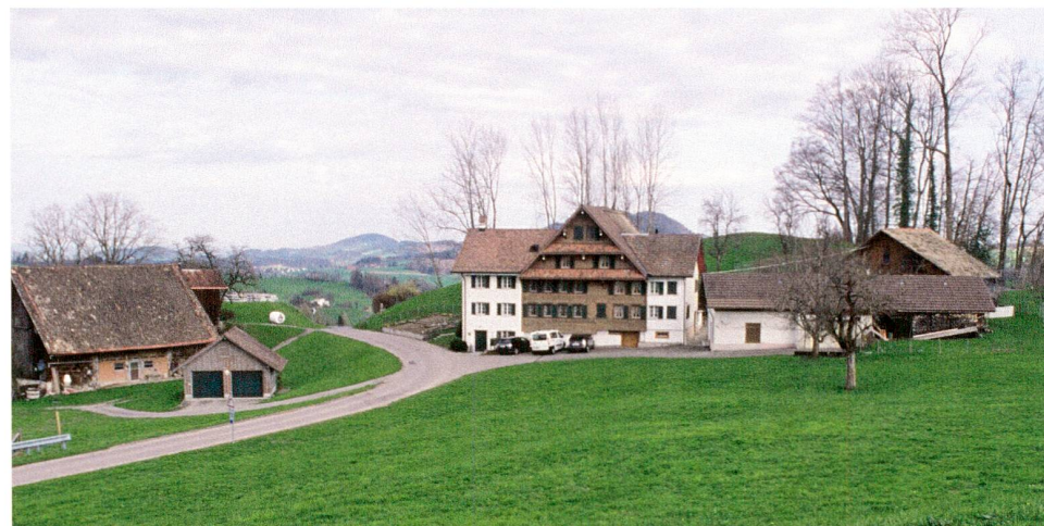
Abb. 36 Neuheim, Hof 2. Den Kern bildet ein Blockbau aus der Zeit nach 1671, der sekundär geteilt und beidseits 1838 bzw. 1844 mit Anbauten erweitert worden ist. Blick nach Nordwesten.
