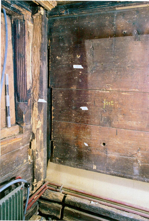
Abb. 2 Baar, Altgasse 5. Bohlenständerbau von 1555. Stube im Erdgeschoss. Links: Stubenfenster und südöstlicher Eckständer von innen. Zu beachten ist der Rillenfries, der den Fensterwagen am Fensterpfosten und am Geschossriegel begleitet.
