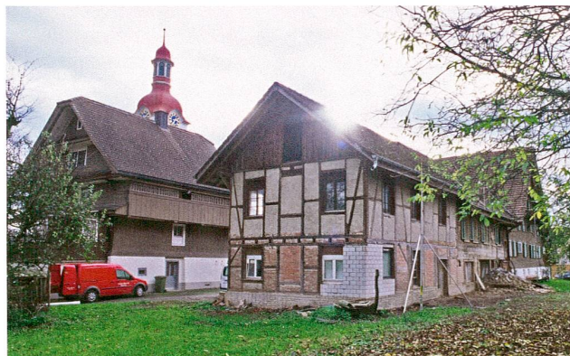
Abb. 29 Cham, Niederwil 10, Wohnhaus/Ökonomiegebäude. Anbau vor dem Umbau mit Blick nach Südwesten.
