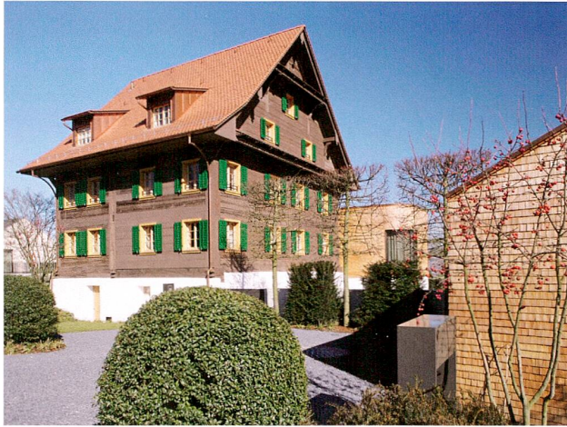
Abb. 45 Risch, Buonas, Dersbachstrasse 4. Bohlenständerbau mit neuem Anbau (hinten) und Carport (rechts). Ansicht von der Dersbachstrasse.
