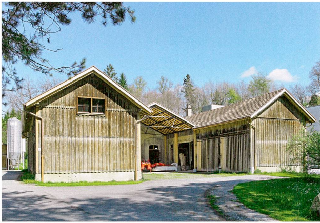
Abb. 33 Hünenberg, Langrüti, Pferdestall. Ansicht von Süden.
