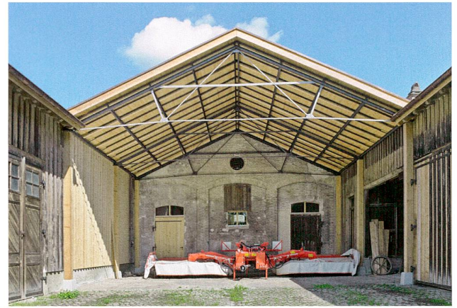
Abb. 34 Hünenberg, Langrüti, Pferdestall. «Ehrenhof» mit Metallüberdachung.
