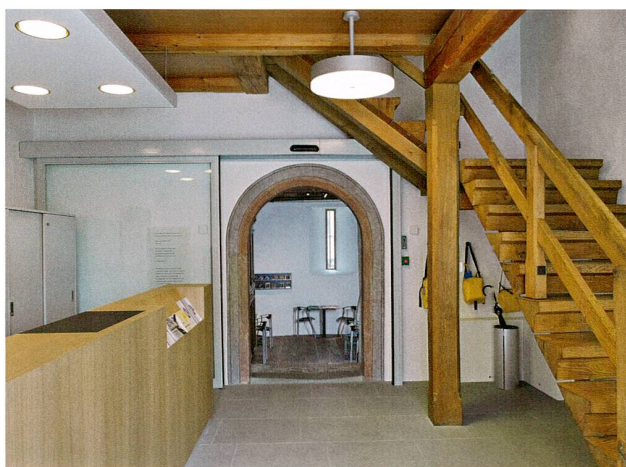
Abb. 60 Zug, Kirchenstrasse 11, Burg. Brandabschnitt mit Brandschutztüre im Korridor, zweites Obergeschoss.
