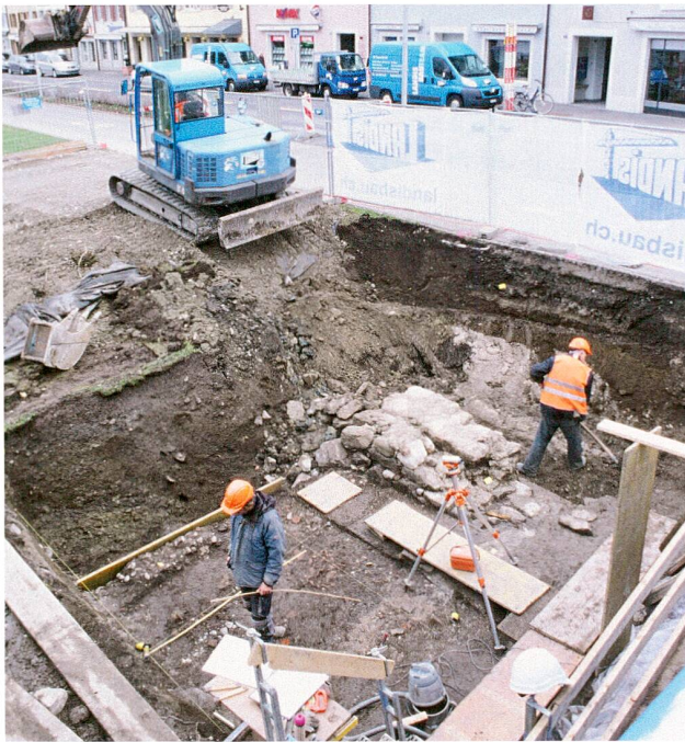
Abb. 67 Zug, Vorstadt, Rössliwiese. Übersicht über die Grabungsfläche nach Nordosten. Die Fläche wurde später Richtung See erweitert.
