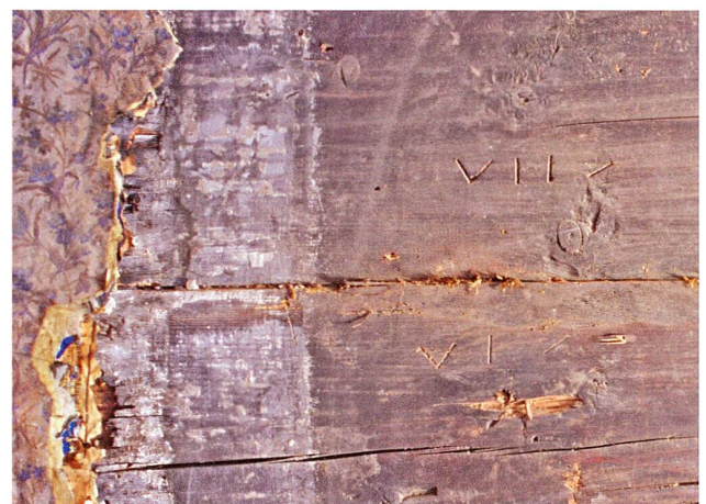
Abb. 57 Walchwil, Zugerstrasse 40, Wohnhaus. Blockwand mit eingestemten Zimmermannszeichen.
