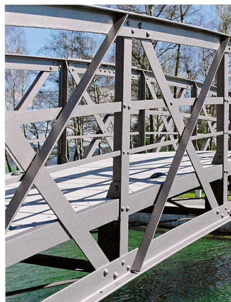
Abb. 53 Unterägeri, Birkenwäldli, Bogenbrücke Lorze. Detail der genieteten Stahlkonstruktion.
