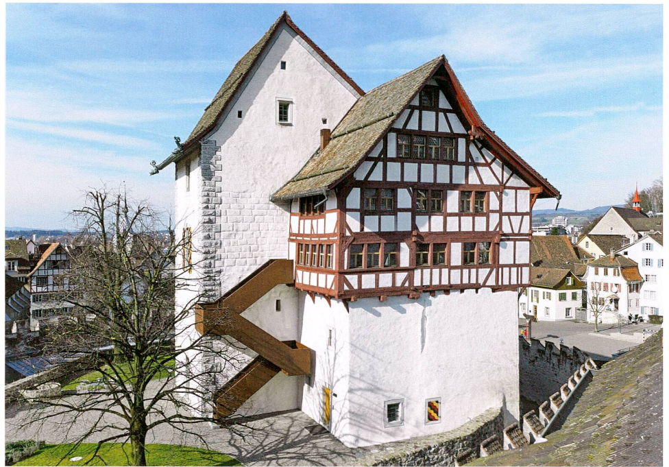
Abb. 59 Zug, Kirchenstrasse 11, Burg. Südostfassade. Deutlich sichtbar vor dem Bergfried die neue Fluchttreppe.
