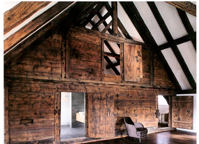
Abb. 48 Risch, Buonas, Dersbachstrasse 4. Restaurierter Dachstuhl.
