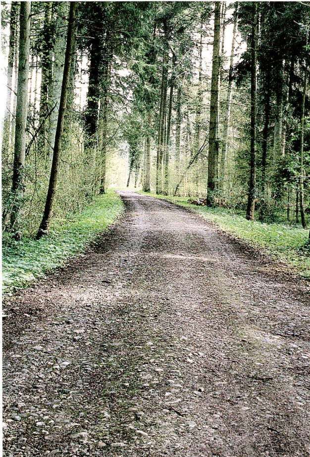
Abb. 4 Die ehemalige Landstrasse im Rainmatterwald bei Hünenberg. Die alte Landstrasse, die von der Stadt Zug zur Reussbrücke bei Sins führte, wurde in der zweiten Hälfte der 1760er Jahre ausgebaut. Ihre Bedeutung als Landstrasse verlor sie 1845/46 mit der Neuanlage der weiter nördlich durch den Herrenwald führenden Strasse. Die verschiedenen Schotterschichten haben sich mit der Erde des Waldbodens zu einer festen Oberfläche verdichtet.
