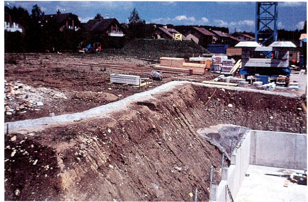
Abb. 10 Steinhausen-Eschenmatt. Blick von Osten auf den Nordrand der Baugrube mit Schnitt 1.
