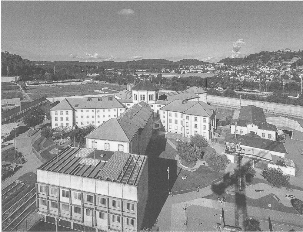
Abb. 3: Justizvollzugsanstalt Lenzburg, 1864 bis heute. Imposante, von fünfeckiger Mauer umschlossene Einrichtung für den Vollzug von Freiheitsstrafen, später auch von administrativen Verwahrungen und strafrechtlichen Massnahmen. Der Gefängnisbau, lange als Kantonale Strafanstalt Lenzburg bekannt, besteht aus einer kuppelartig überdachten Zentralhalle, von der strahlenförmig fünf dreistöckige Flügel ausgehen. Vier Flügel bestehen aus jeweils 55 Zellen, ein Flügel enthält die Verwaltung. Im Vordergrund des Bildes ist der 1995 eingerichtete Sicherheitstrakt (sitrak) mit acht Plätzen erkennbar. 2007 umbenannt in Justizvollzugsanstalt, wurde ihr 2011 das Zentralgefängnis des Kantons Aargau mit 90 Haftplätzen für die Untersuchungshaft angegliedert. (Foto: Peter Schulthess, 2013)
