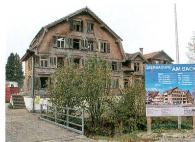
Die Liegenschaft Wenk vor dem Abbruch.
