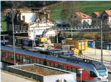
Der Bahnhof Brunnadern wird abgebrochen.
