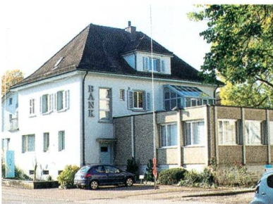
Das jetzige Bankgebäude wird abgerissen.
