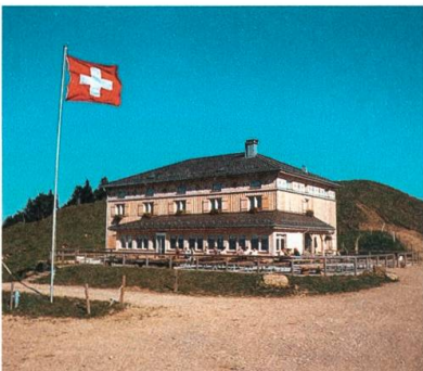
Das Berggasthaus Chrüzegg spart Energie und Treibhausgase.
