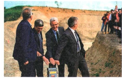
Erste Sprengung für die Umfahrung.
