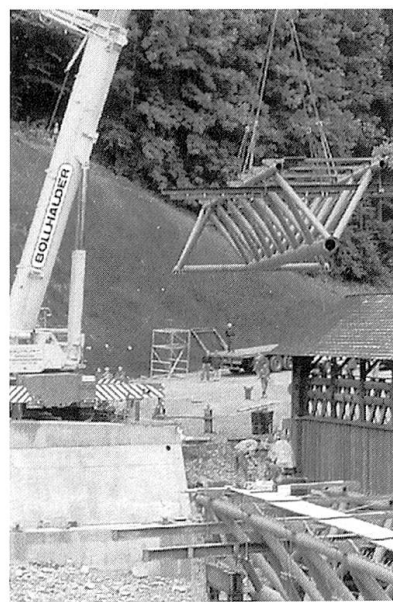
Einbau der Stahlträger.
