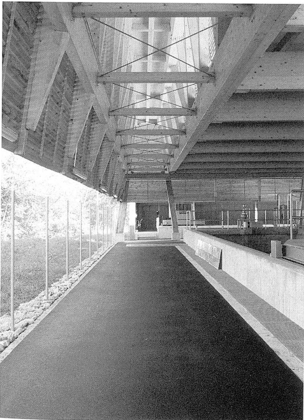
Das Dach wird getragen und stabilisiert von einem Binderwerk aus Holz.
