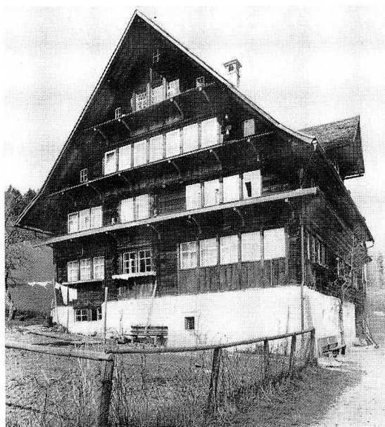
Ebnat-Kappel. Haus im Ganten, erbaut 1687 von der Familie Federli. «Gewappnete» Front mit grosser Firstkammer. – Foto B. Anderes, Rapperswil.
