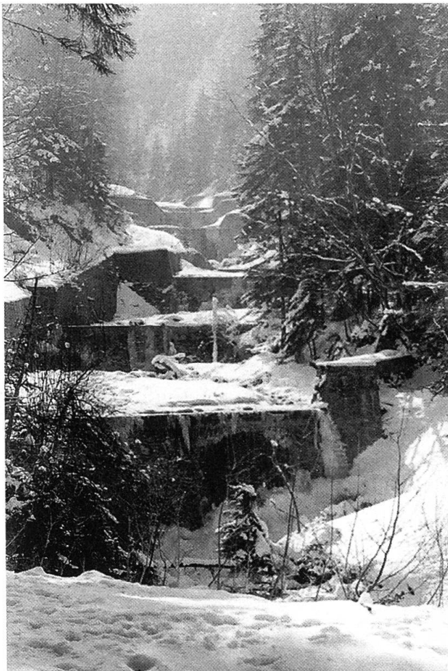
Figure 5. Les nombreux barrages en béton construits dans les années 70 ont coûté des fortunes.
