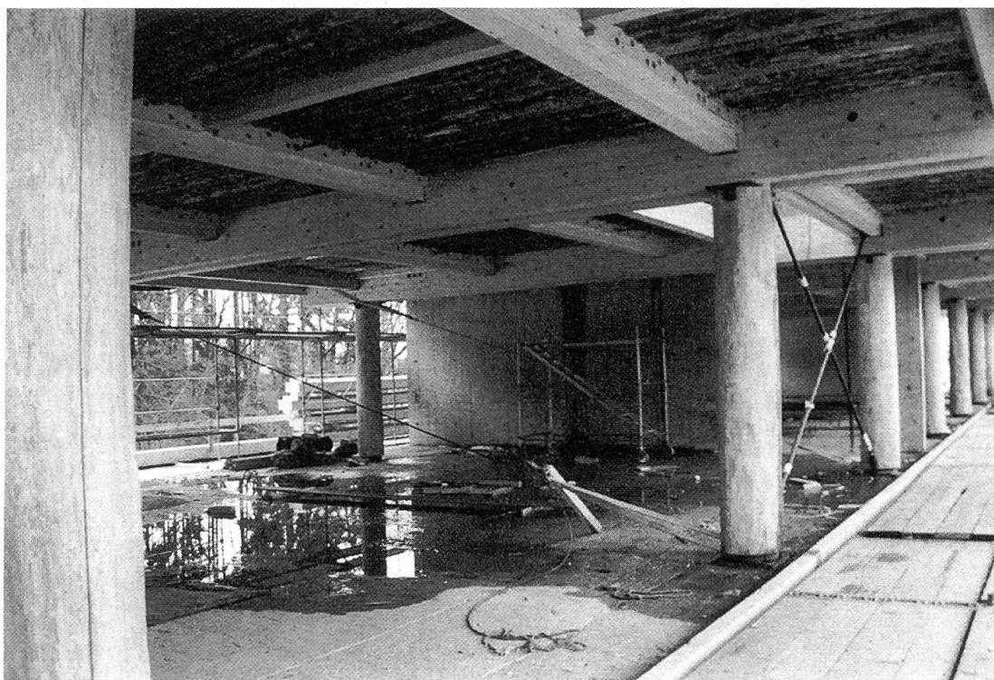
Figure 3. Construction de l'école de gardes forestiers à Lyss, 1996 (Photo F. Schneider).
