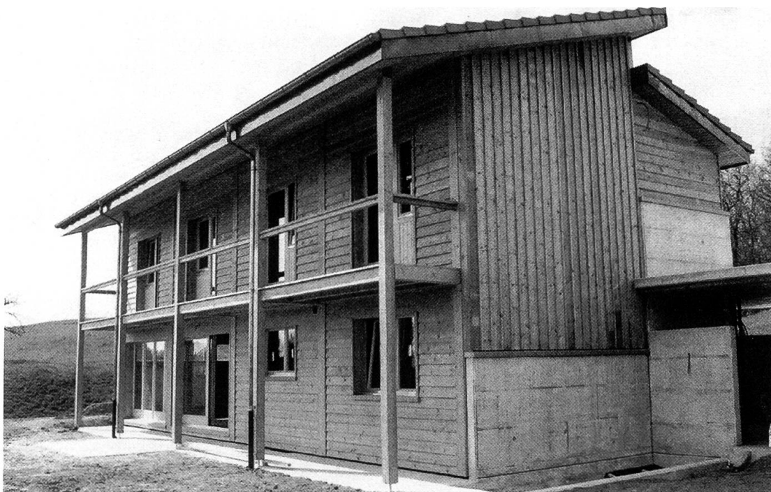
Figure 4. Villa à ossature en bois, 1996 (Photo P. Sallin).
