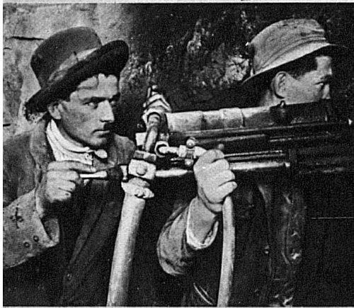
Mit Feuereifer setzen die Mineure ihre wildratenden Bohrhämmer zum letzten Angriff an
