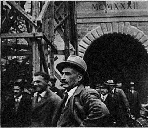
Geometer Spörri hat die beiden Stollen mit grosser Präzision zusammengeführt
