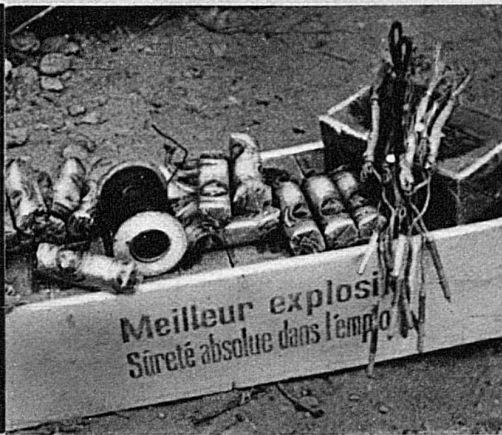
Das war die letzte Ladung vor Ort, 25 kg Aldorfit mit Kapseln und Zündschnur für elektrische Zündung
