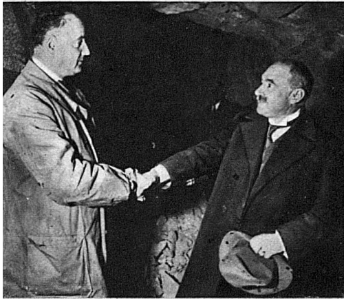
Herr Kreisdirektor Labhardt in Luzern beglückwünscht den bauleitenden Ingenieur Forni zum gut gelungenen Werk
