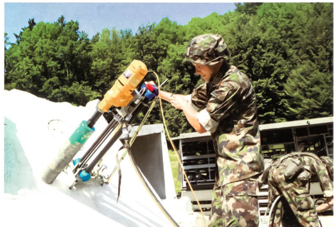
Einsatz des elektrischen Kernbohrgerätes.
