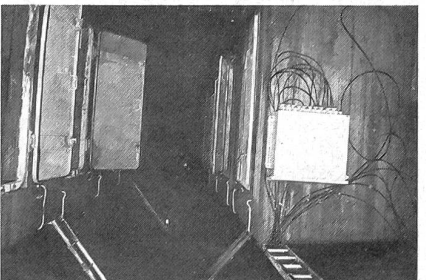
Ein Blick in den Bergraum mit Kammer für den Erdbebenmesser.
