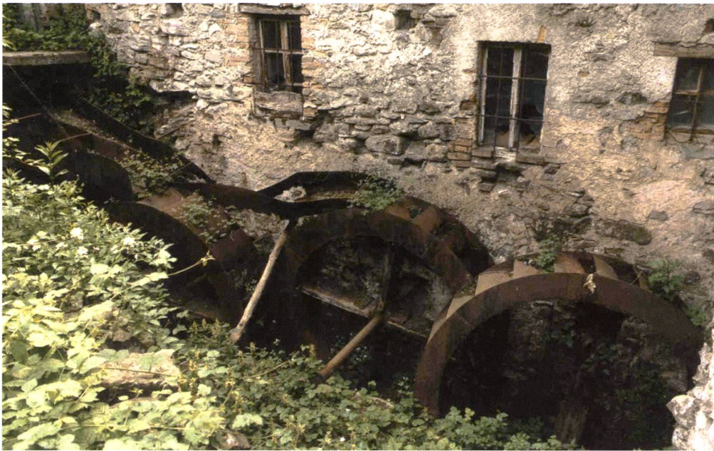
Le ruote del mulino prima dei lavori di restauro.
