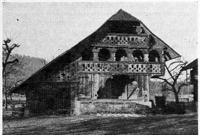
Speicher (Langnau i. E., 1722)
