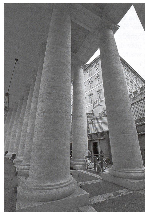
Die «Servizi» hinter den Kolonnaden und unter dem Apostolischen Palast von aussen (© Osservatore romano).
