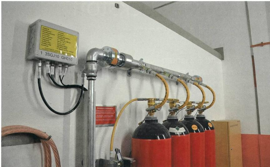
Die Hochdruckstahlflaschen lagern den Stickstoff bei 300 bar.
