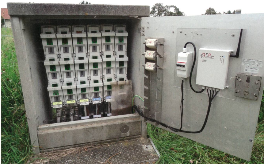
Bild 2 Verteilkasten mit einem GridEye-Modul.
