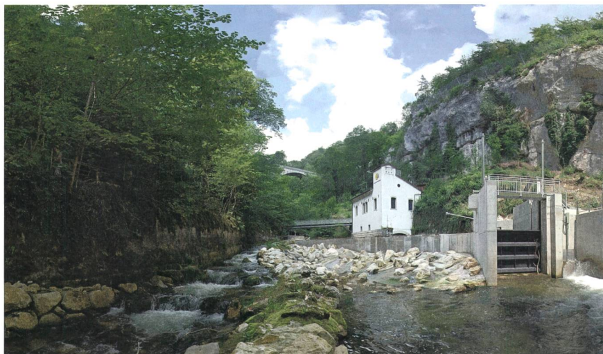
Bild 4 Das Kraftwerk Taubenloch von ESB wurde 2006 Naturemade-Star-zertifiziert. Mit verschiedenen Kommunikationsinstrumenten wird die Kundschaft seither über verschiedene Aspekte der Wasserkraftnutzung informiert.
