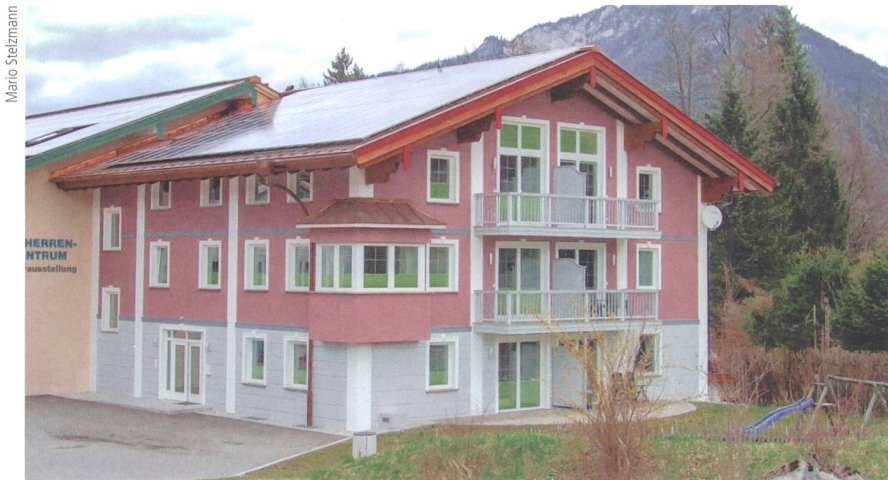
L'immeuble « Effizienzhaus Plus » de Bischofswiesen génère plus d'énergie qu'il n'en consomme.
