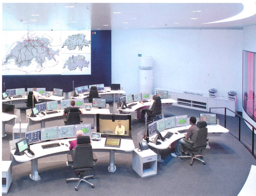
Die Schweizer Stromversorgung ist ein hochkomplexes System, das ein abgestimmtes Zusammenspiel verschiedenster privatwirtschaftlicher und staatlicher Akteure erfordert. Im Bild: Netzleitstelle von Swissgrid in Laufenburg.
