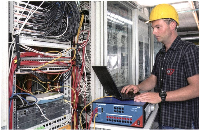
Signalanalyse in einem hybriden System mit Daneo 400.
