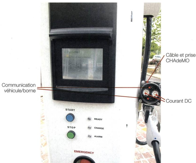
**Figure 2** Borne de recharge rapide de 44 kW de puissance, munie d'une prise CHAdeMO.
