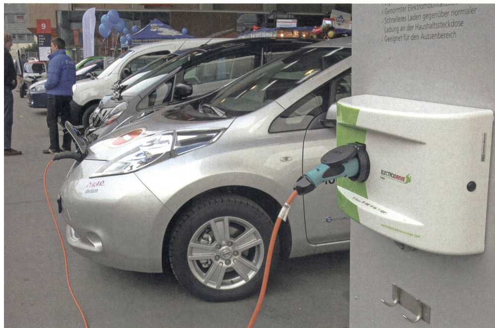
Bild 2 International einheitliche Ladestandards werden den Ausbau der entsprechenden Infrastruktur beschleunigen.
