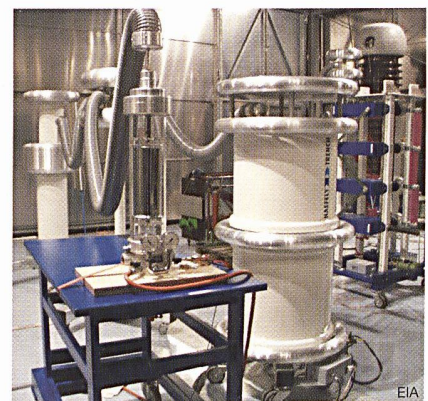
Hochspannungslabor der EIA Fribourg mit der 200-kV/50-Hz-Anlage
