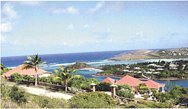
Mit einer innovativen Anlage möchte die EDF die Effektivität der Netzwerke in den Karibikinseln verbessern. Zudem muss EDF in Regionen wie den französischen Antilleninseln den Strom zu gleichen Konditionen anbieten wie in Frankreich (im Bild Saint Barthélemy).
