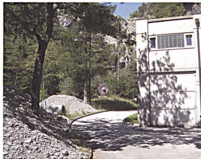
Die neue Zentrale kommuniziert über das Standardprotokoll IEC-60870-5-104
