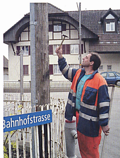
Kontrolle der Holzleitungsmasten.
